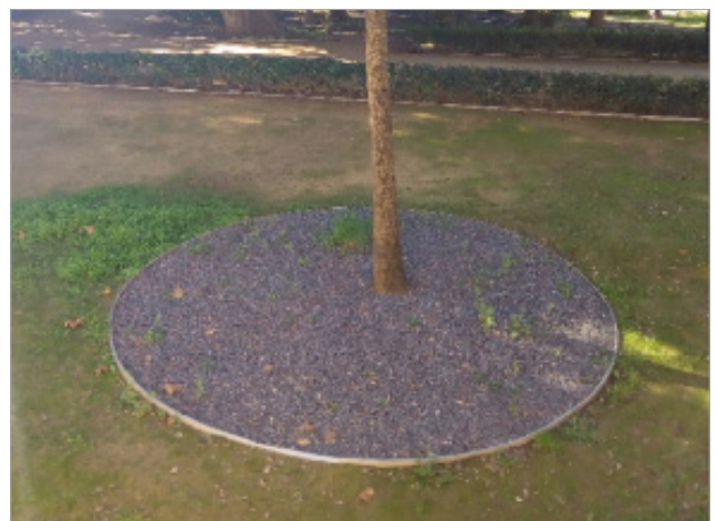
Imagen 1.5_40. Alcorque cubierto con gravilla. La gravilla permite la circulación al agua y del aire de forma razonable.
