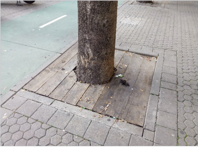
Imagen 1.5_35. Alcorque cubierto con planchas de madera.
