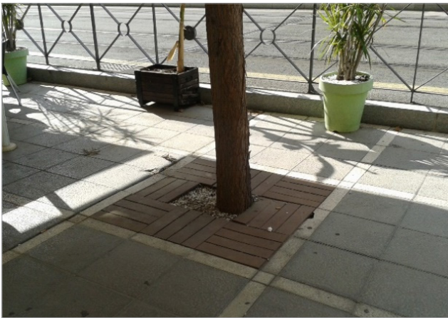
Imagen 1.5_31. Alcorque cubierto con losetas de pavimentación.
