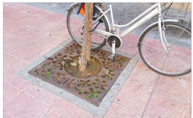
Imagen 1.5_34. Alcorque cubierto con una estructura metálica de fundición, que permite por sus perforaciones artísticas la circulación del agua y el aire.
