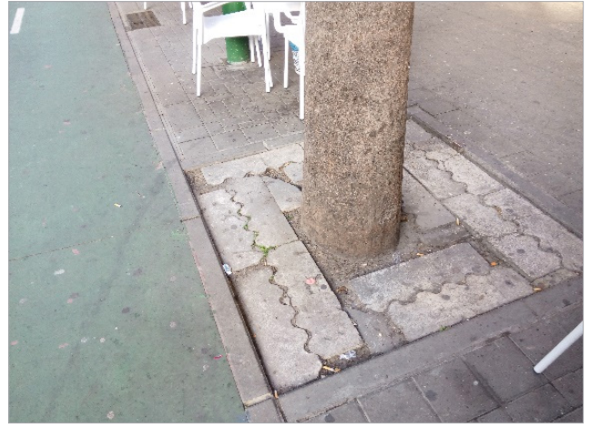
Imagen 1.5_36. Alcorque cubierto con losetas de hormigón.
