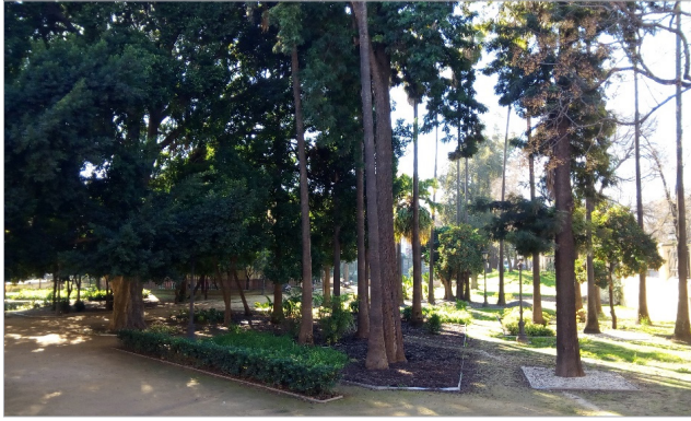
Imagen 1.5_41. Alcorque de ajardinamiento cubierto con corteza se pino y alcorque individual con grava. Estos materiales permiten la circulación del agua razonablemente, así como la del aire.
